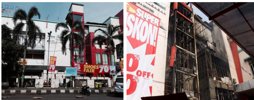
Gambar 1 Pasar Banjarsari Kota Pekalongan sebelum dan sesudah kebakaran
